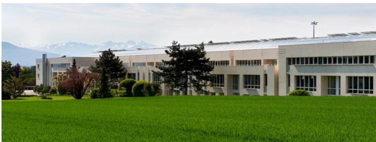
Vue de la Terrasse
