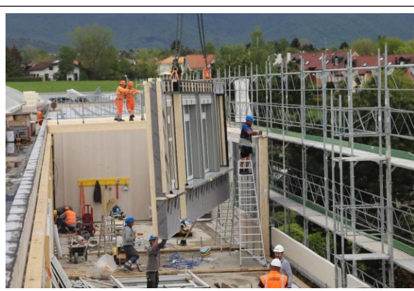
Pose des éléments de façades
