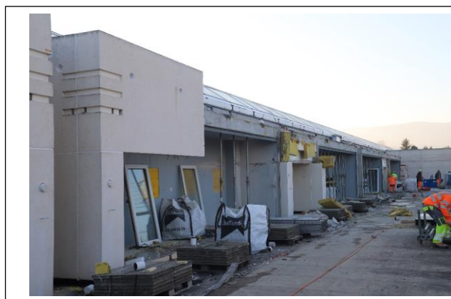
Travaux de démolition
